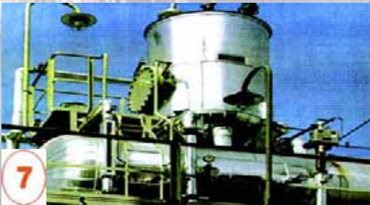
7 TANQUE DE ALIMENTACION Y DESGASIFICACION Diseñados conforme a las necesidades de alimentación de la caldera, en diversos materiales y totalmente equipados para su instalación final.
